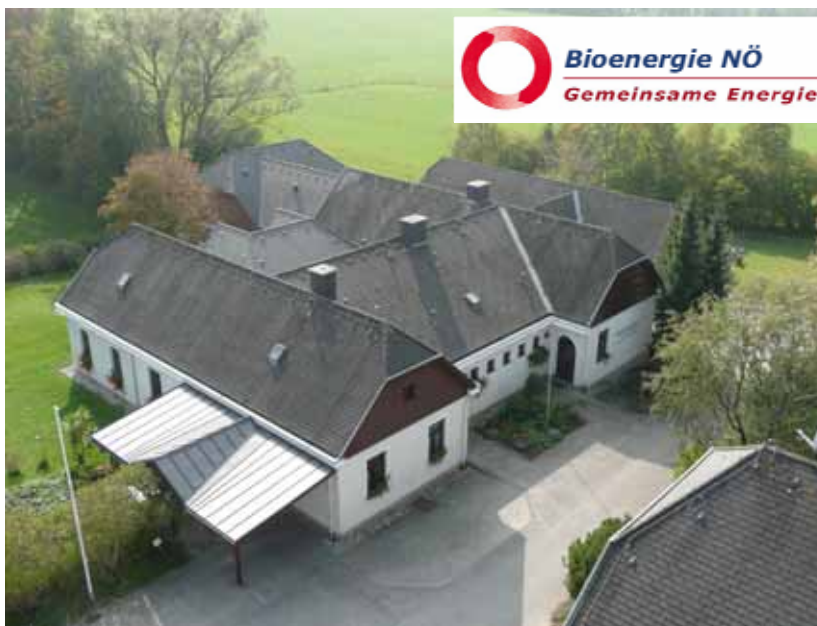
Lebenshilfe - Werkstätte Rogatsboden setzt auf die regionale Wärme der Bioenergie NÖ (Foto zur Verfügung gestellt von Fr. Mock, Leiterin Werkstätte Rogatsboden)
