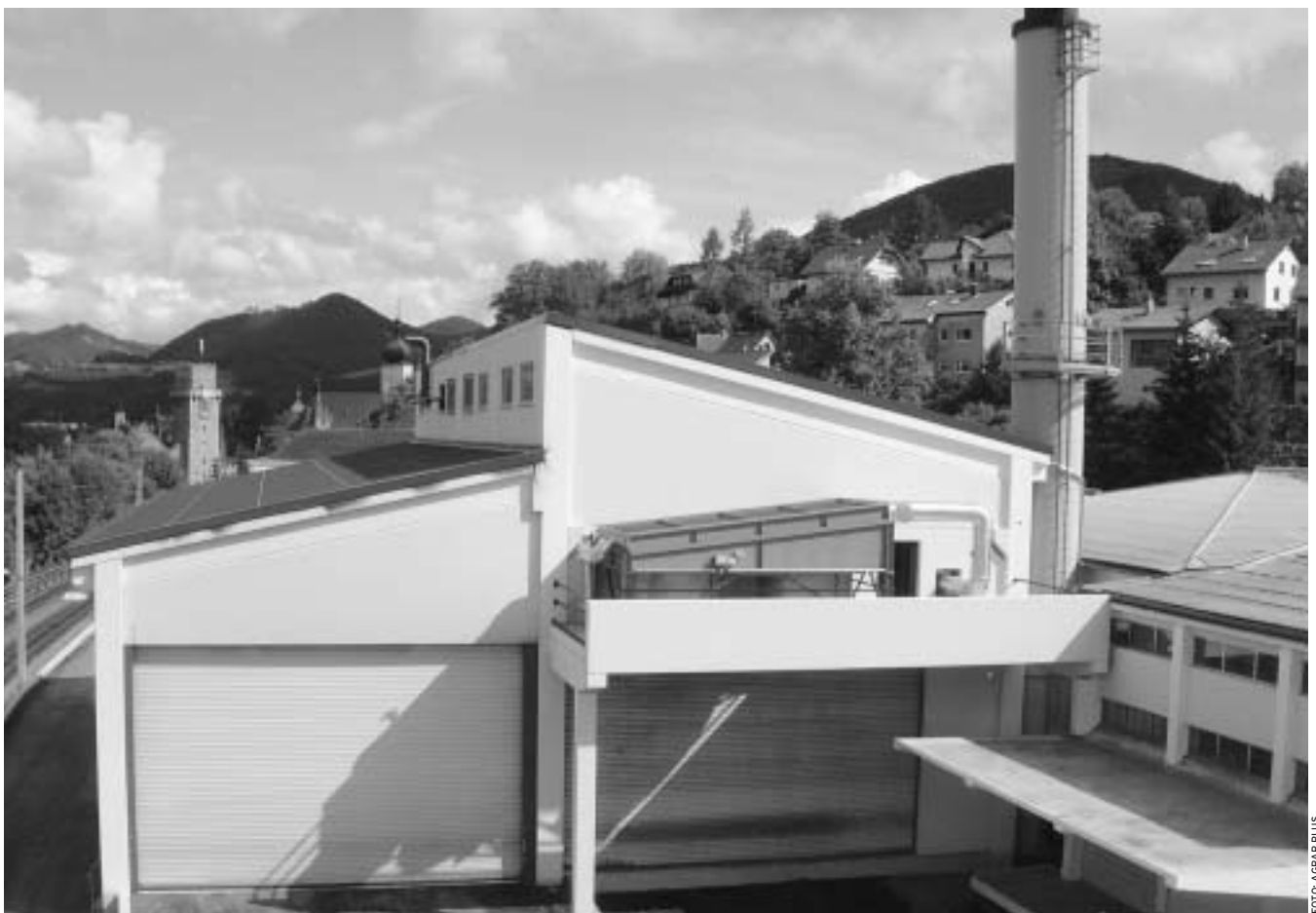
Das Kessel- und Turbinenhaus des Biomasse-Heizkraftwerks am Areal der Molkerei in Waidhofen/Ybbs.
