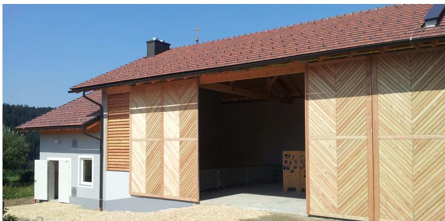
Der Neubau der Bioenergieanlage fügt sich durch seine ortsübliche Bauweise harmonisch in das Ortsbild von Dorfstetten ein.
