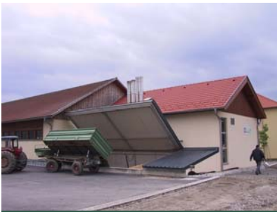
Die Bioenergie NÖ Anlage Mold wird von neunzehn regionalen Land- und Forstwirten betrieben. Foto: Bildungszentrum Mold
