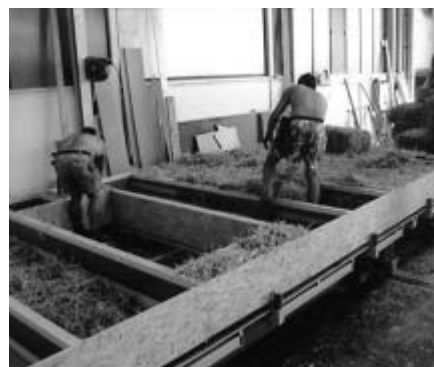
Im Fertigteilerwerk werden die Wände mit Strohballen ausgestopft.
