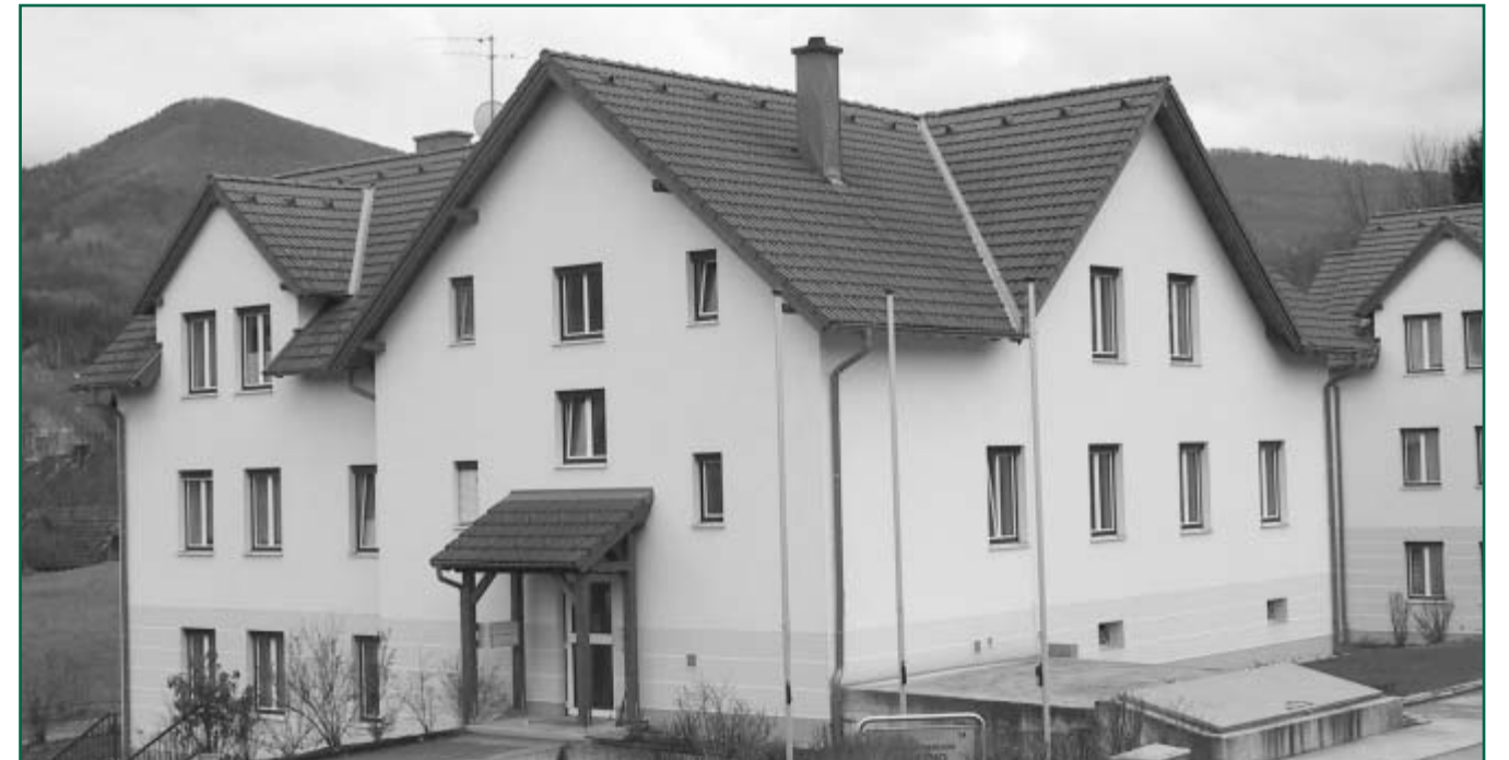
Seit 1998 läuft die Biomasseheizung der Wohnhausanlage in Texing zur Zufriedenheit aller Mieter. Mit den jetzigen 12 Wohneinheiten (und in naher Zukunft 18 Wohneinheiten), aufgeteilt auf drei Wohnobjekte, präsentiert sich diese Wohnhausanlage als Musterbeispiel für die Realisierung von Biomasseobjektversorgung im Wohnbau.
