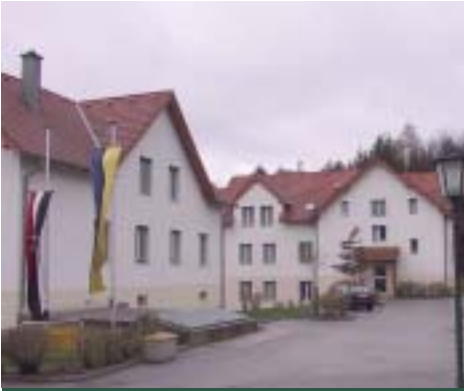
Nahwärmeversorgung für Wohnanlage in Texing
