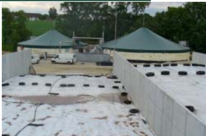
Die Biogasanlage Wallsee steht vor der Fertigstellung und ist ähnlich konzipiert wie Margarethen/Moos
