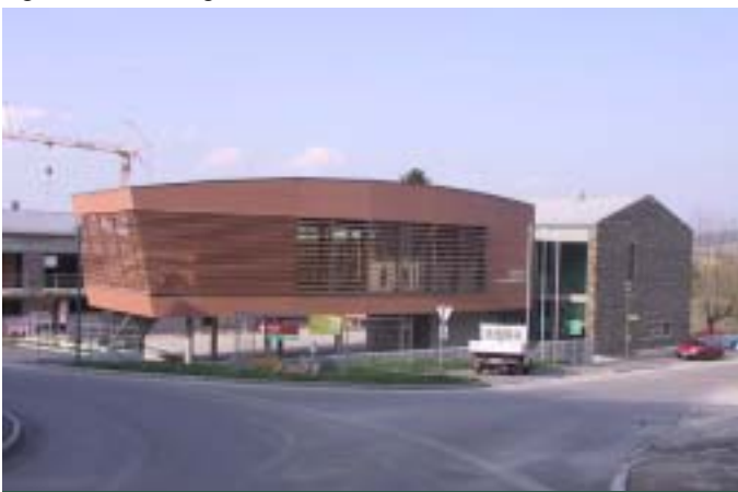
Umweltfreundliche Biomasse für das neue Gemeindezentrum, Wohnungen und Reihenhäuser in Stephanshart
