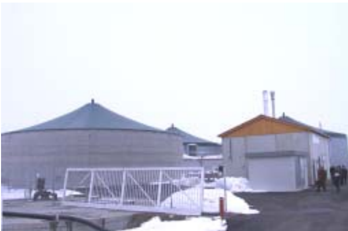
Seit einigen Monaten in Betrieb: Biogasanlage Margarethen//Moos. Bereits in der Startphase 100 Prozent Leistung
