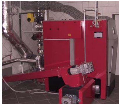
In Haunoldstein wird das 44. Biomasseheizwerk der BENO bis zur nächsten Heizsaison fertig gestellt.
